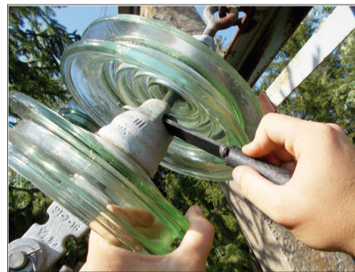
Применение приспособления для демонтажа подвесных изоляторов
