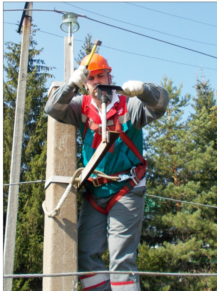
Нияз Шаяхметов производит демонтаж изоляторов с помощью специальных приспособлений
